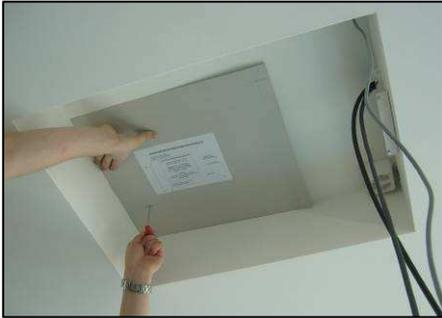
Mit der mitgelieferten Kartonschablone werden die 4 Dübellöcher an der Decke angezeichnet. Die Schablone muss an den zwei bezeichneten Seiten an den Nischenwänden anliegen. Angaben auf der Schablone genau beachten! Dübellöcher ca. 30 bis 35 mm tief, 8mm Durchmesser bohren! Lift in Originalverpackung lassen, damit er während der nun folgenden Phase des Betonbohrens vor Staub geschützt ist. Es ist während der gesamten Montage- und Deckenbauzeit auf Staubfreiheit am Lift zu achten.
